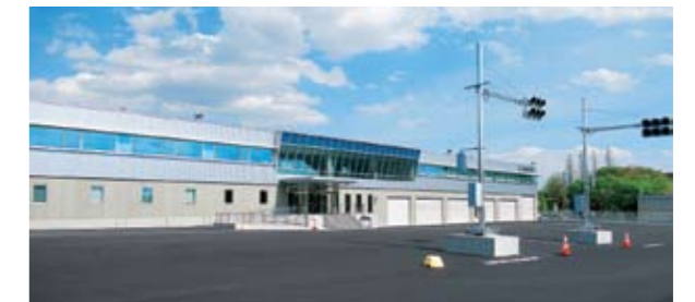
研究開発の拠点となる建物は2階建て。車両整備開発室、管制・遠隔運転室、データセンター、シミュレーション室を備えているほか、共同研究先が研究室として使用するための部屋が多数ある。建物の前に実験路が併設されている。実験路の面積は約6,000平方メートル。
