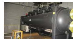
ガス式の冷水発生機を、電気式の高効率な磁気軸受ターボ冷凍機に更新。更新前の設備に比べ、約3倍の高効率運転が可能に
